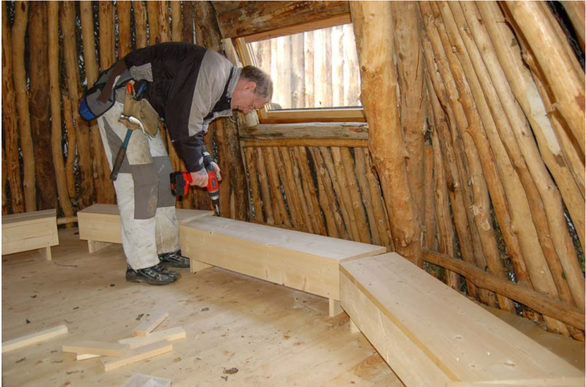
Bilde 17 Montering av benkene.
