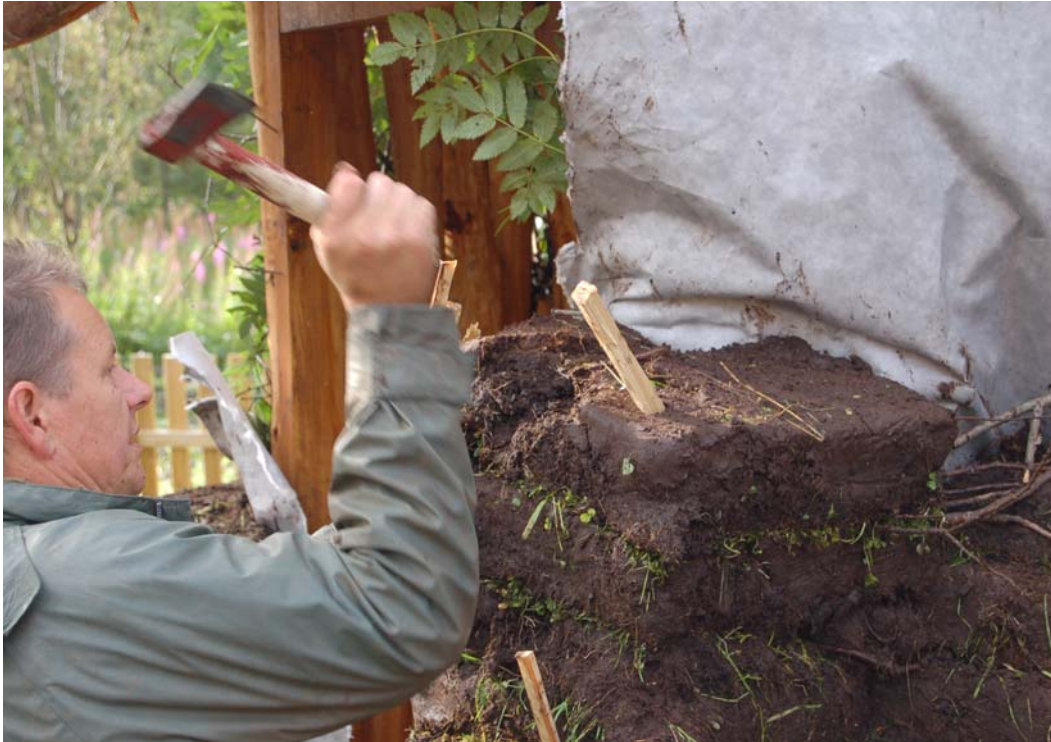
Bilde 16 Vertikal armering.
