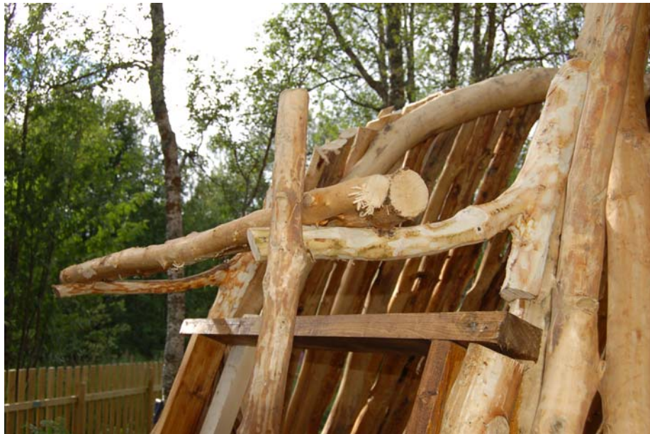
Bilde 14 Løsning for vannbrett over vinduet.
