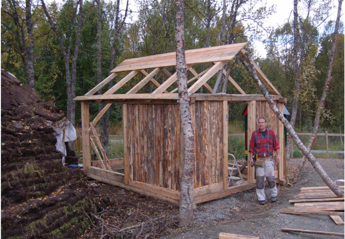
Bilde 24 På bildet ser en hvordan skjeltrene tres inn mellom de liggende stukkene med spor i.
