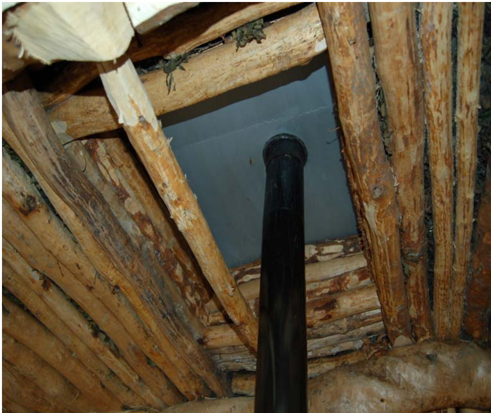
Bilde 20 Riehpén med ovnsrørløsningen sett fra innsiden.
