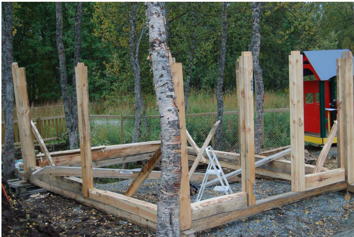
Bilde 23 Grunnkonstruksjonen trer frem.
