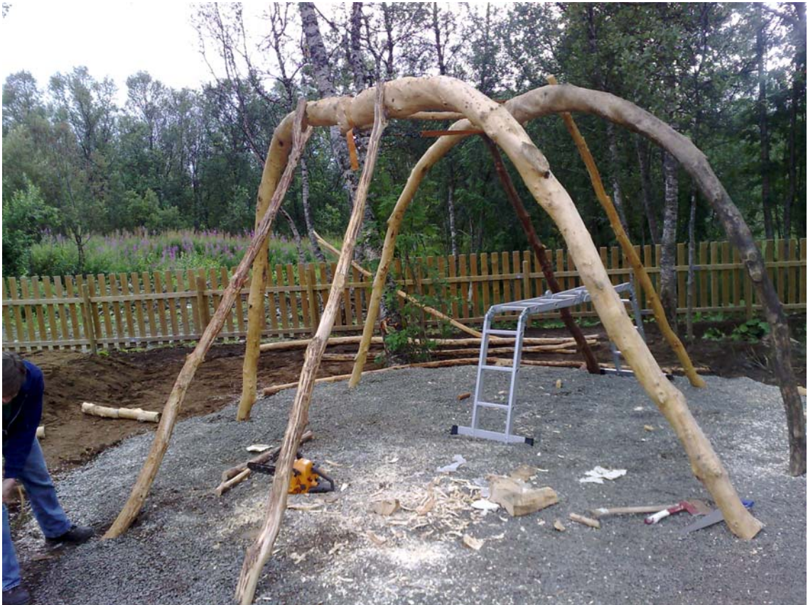
Bilde 12 Ådnårsá og y-stokker ferdig oppsatt.
