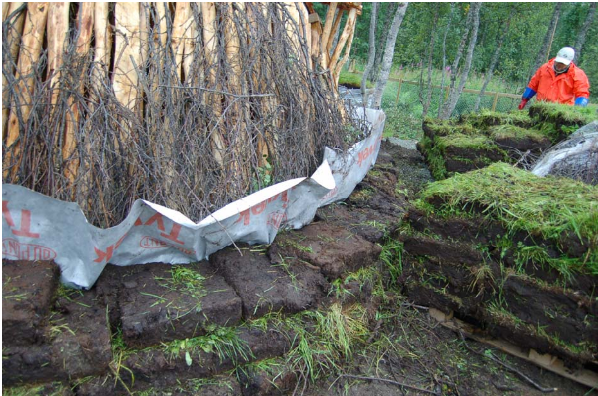
Bilde 15 Torv, Tyvek og bjørkeris lagt mot dæhkága.
