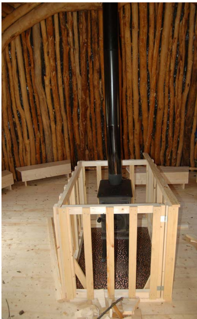
Bilde 19 Ovn med grind (barnesikring) rundt.
