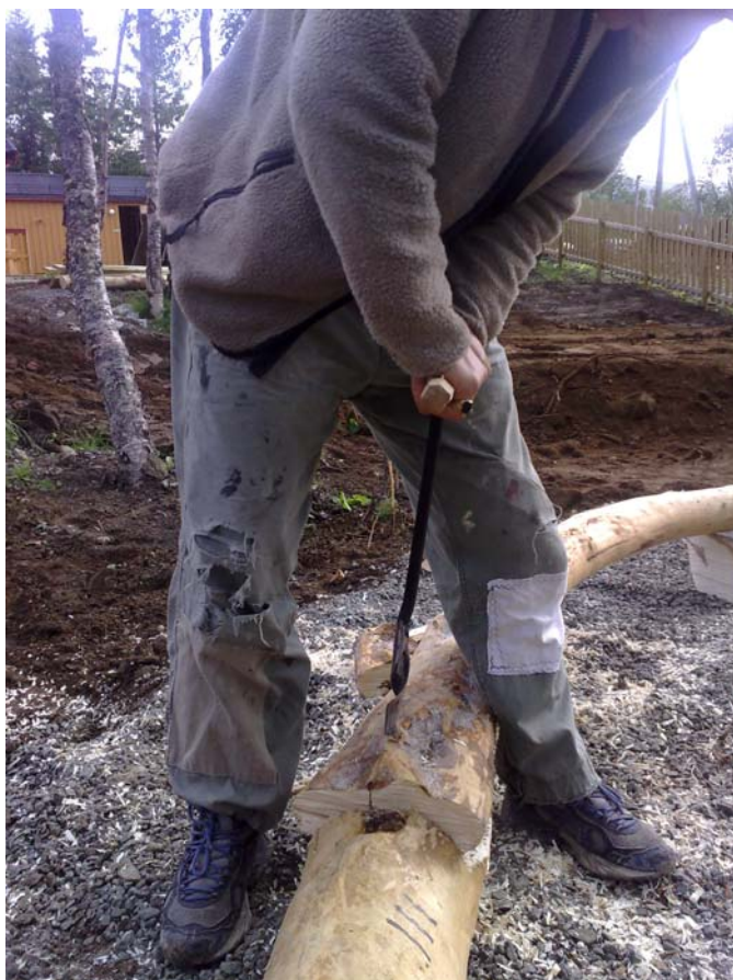
Bilde 11 Boring med navar gjennom ådnårsá.
