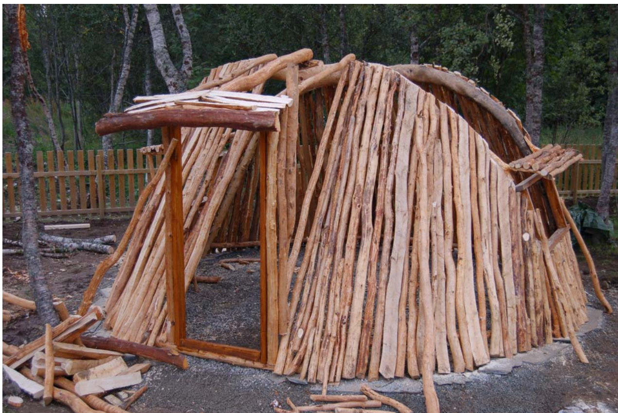
Bilde 13 Grunnkonstruksjonen med dæhkága, dør- og vindusløsningene og steina synlig.
