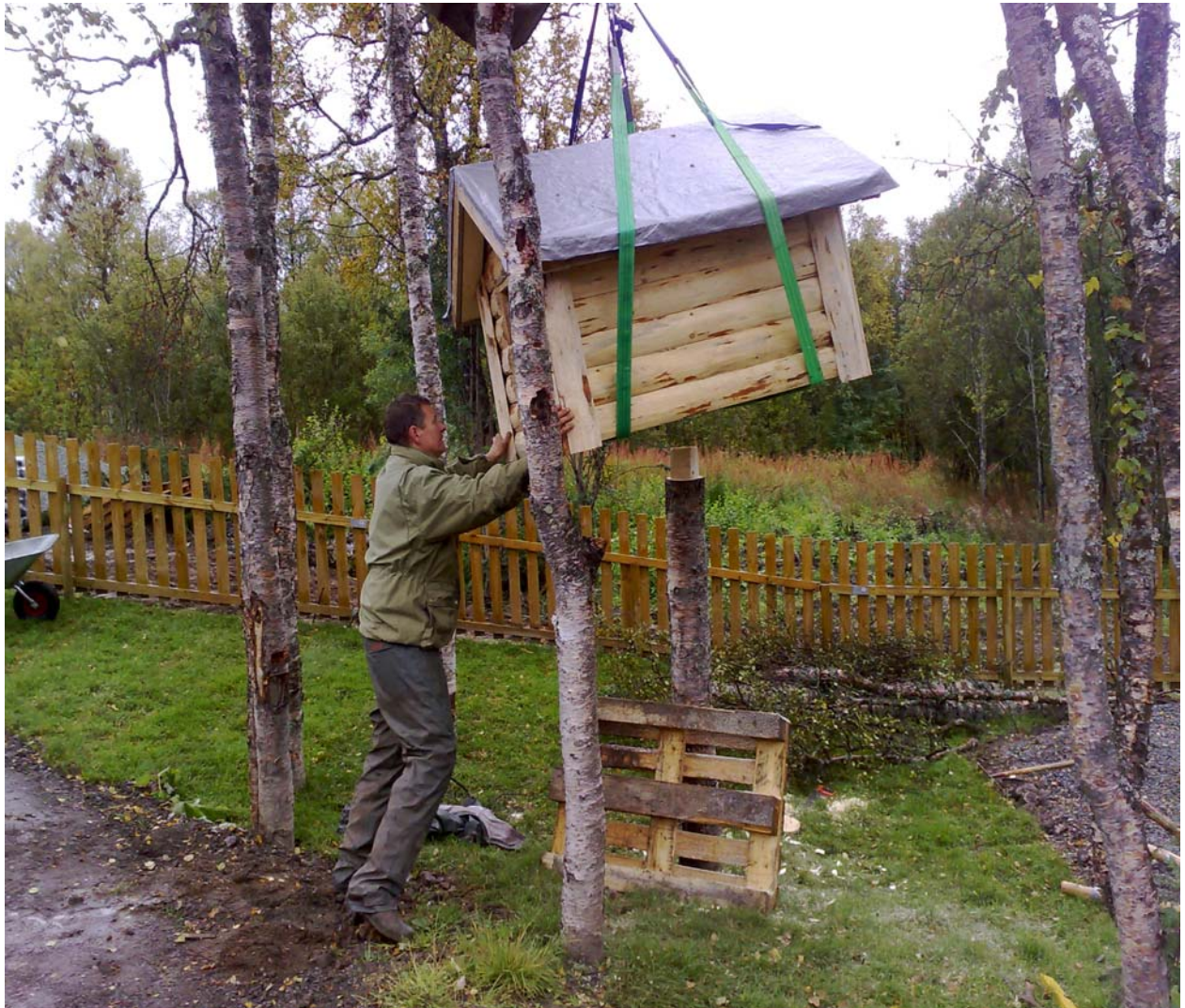
Bilde 21: Sander setter njalla'en på plass. (Ja det er gravemaskin utenfor bildet).
